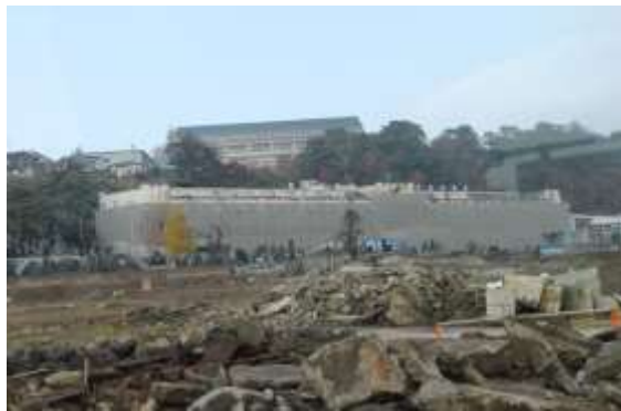
車窓から被災地を視察（門脇小跡）
